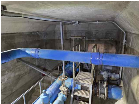
유입밸브실 내부 전경
