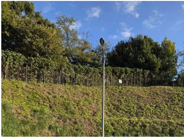
손상내용 안전휀스 상태양호
