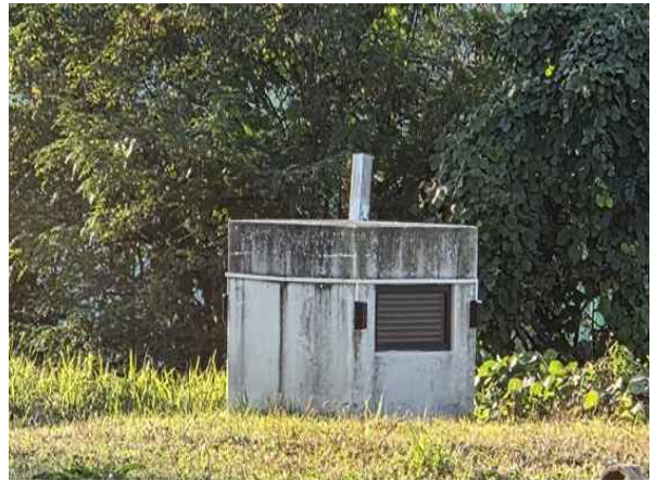
손상내용 환기구 상태양호
