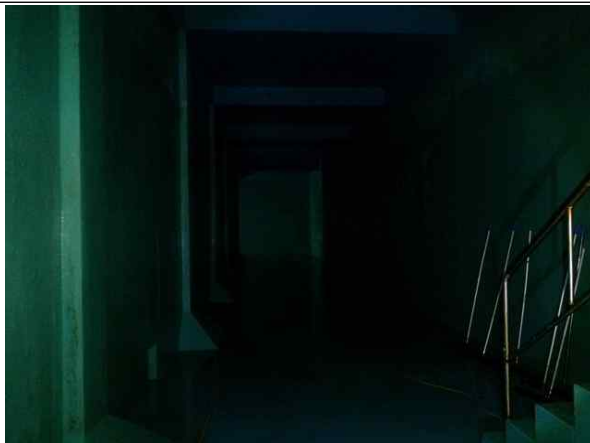
배수지 1지 내부 전경
