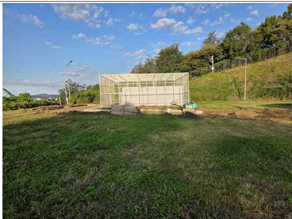
배수지 상부 현황
