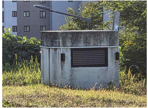
환기구 등의 덮개(장비 반입구) 현황
