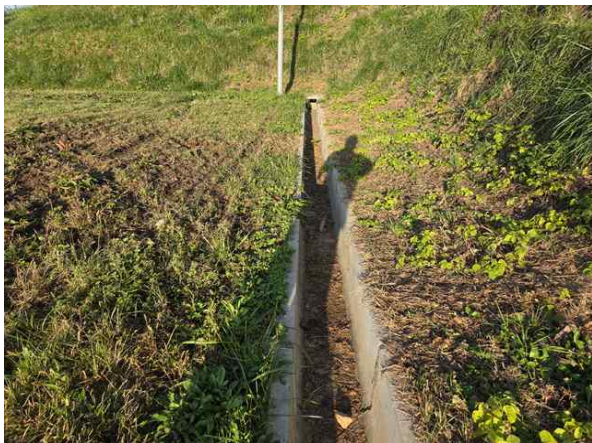
손상내용 배수로 상태양호
