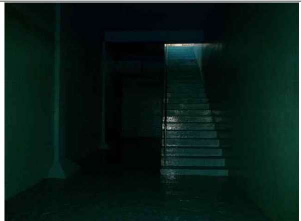
배수지 2지 내부 전경
